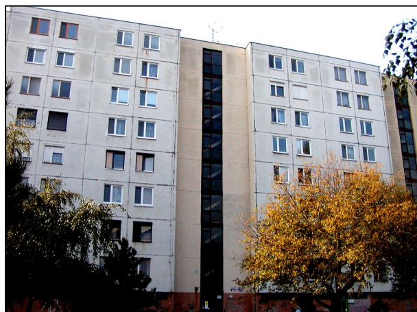
Obr. 4.14.1 Radový dom B-70 (Bratislava, Dopravná ul.)
