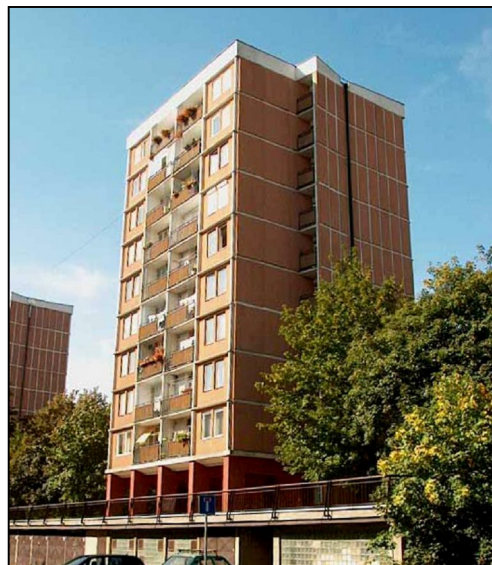
obr. 4.3.2 Pohľad na bodový dom LB (Bratislava J.C.Hronského)
