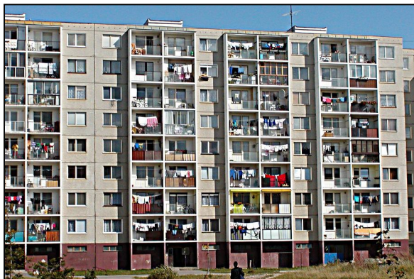
Obr. 4.19.1 Radový dom PS-82-PP (Poprad)
