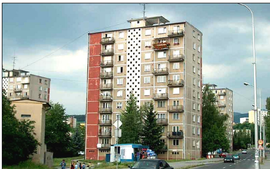
Obr. 4.4.4 Pohľad na bytovým dom MS 11(Zvolen)
